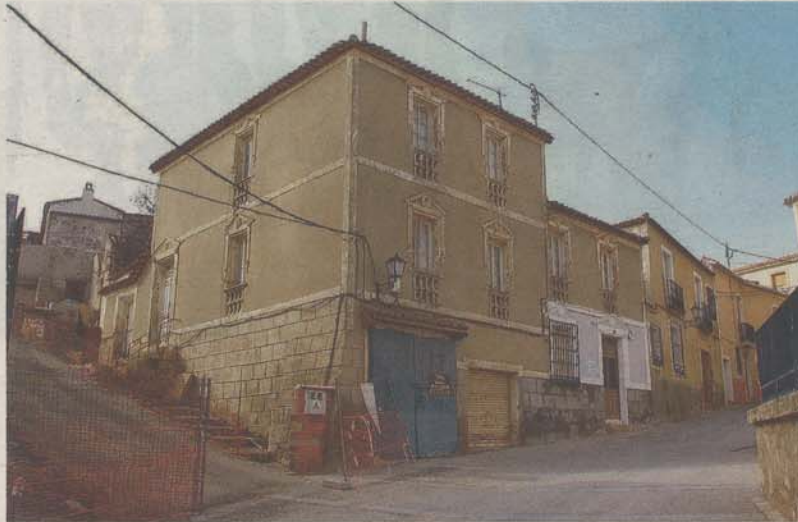
Los baños árabes se encuentran en el sótano del edificio que hace esquina. / R.S.
